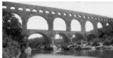
Akwedukt - wodociąg rzymski
